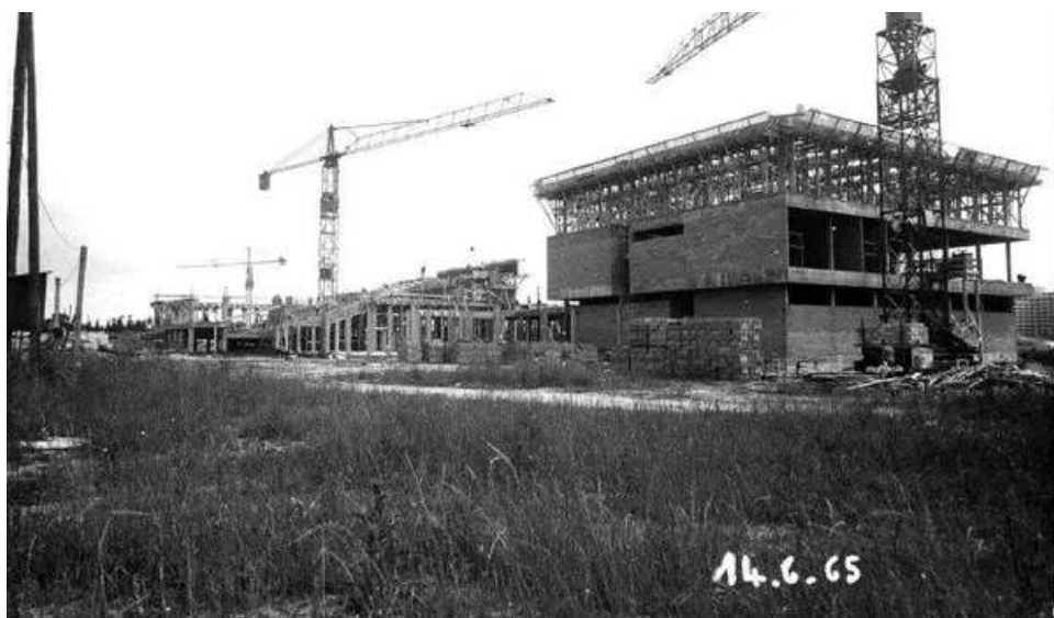
Construction de l'école nationale de santé publique (1965) maintenant sous l'appellation Ecole des hautes études en santé publique (EHESP). Direction de la communication EHESP, CC BY-SA
